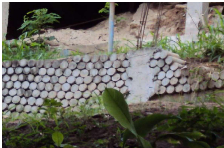
Figura 1: Contenção do terreno construída com corpos de prova
