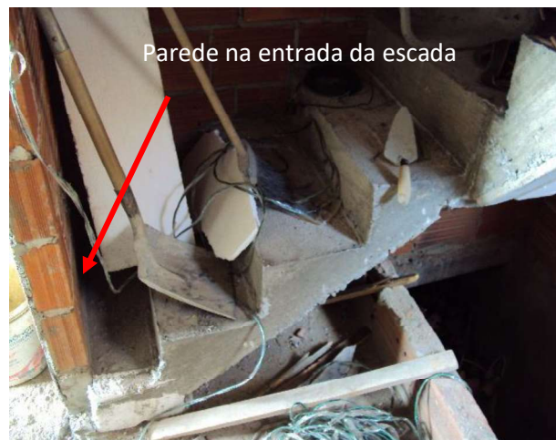
Figura 3: Escada terminando na parede
