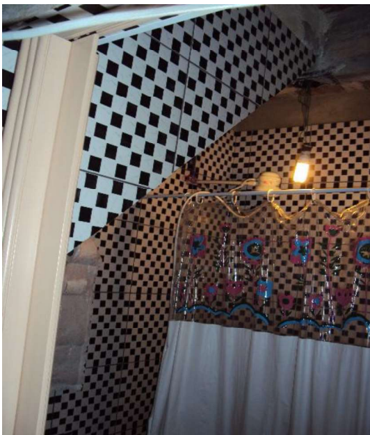
Figura 4: Revestimento cerâmico imitando pastilhas.
